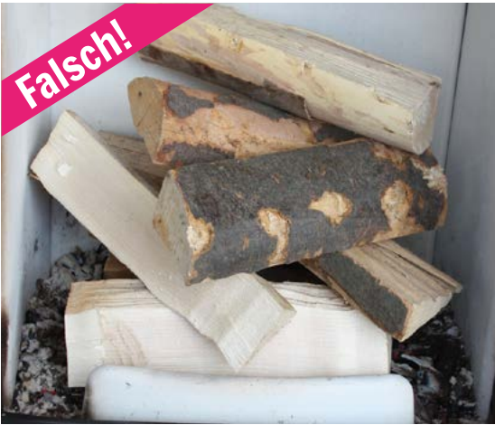
Falsches Nachlegen bei einem Kaminofen Nicht überladen!
