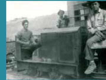
Abtransport des Lehms in Stadtbergen.
