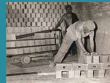
Einschichten der Ziegelrohlinge in die Brennkammer (Ziegelei Schweiger, Göggingen).
