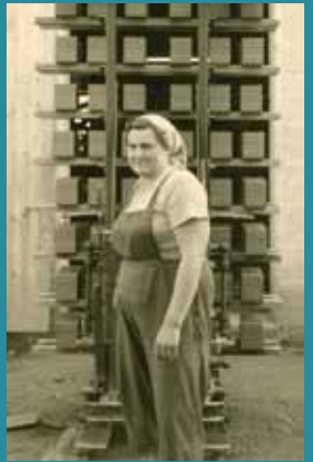
Absetzwagen mit getrockneten Ziegeln (Stadtbergen).
