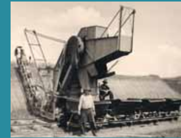
Der Abbaubagger in Göggingen.
