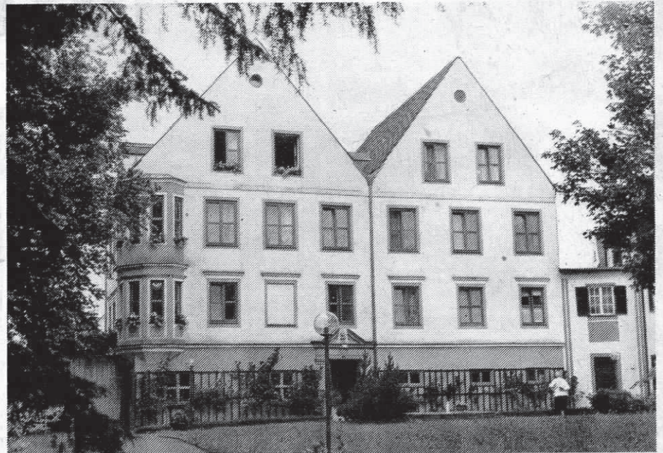
Stilvoll modernisiert präsentiert sich jetzt das zum Altenheim umgebaute Gebäude, das den Erfordernissen der Zeit angepaßt wurde.
