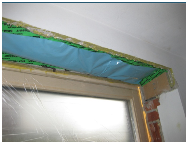
Abb. 20: Die beste Lösung ist es oft, alte Rollläden stillzulegen und an die neuen Fenster außenliegende Rollläden anzubringen.
