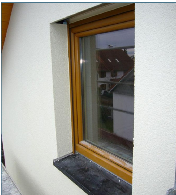
Abb. 4: Dank der – bereits bei der Planung berücksichtigten – nach außen in die Dämmschicht verlegten Position der Fenster ergeben sich auch bei fast 30 cm Dämmstärke keine „Schießscharten“.
