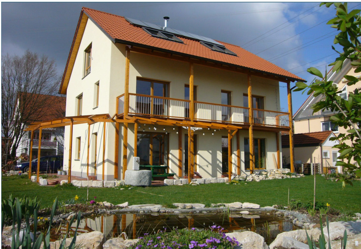
Abb. 17: Passivhäuser sind rein äußerlich von herkömmlichen Häusern nicht zu unterscheiden.
