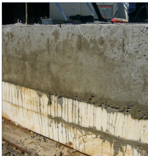
Abb. 12: Wärmedämmung unter der Bodenplatte im Neubau (Perimeterdämmung).
